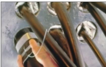
Mit der handlichen Füllvorrichtung wird der Beutel mit einem Gasdruck von 3 bar gefüllt, sodass die Dichtmasse an die Innenseite des Rohres wie auch an den Kabelmantel gepresst wird.
