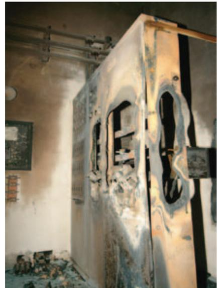
**Bild 4** Beschädigte Schaltgerätekombination durch Kurzschluss.
